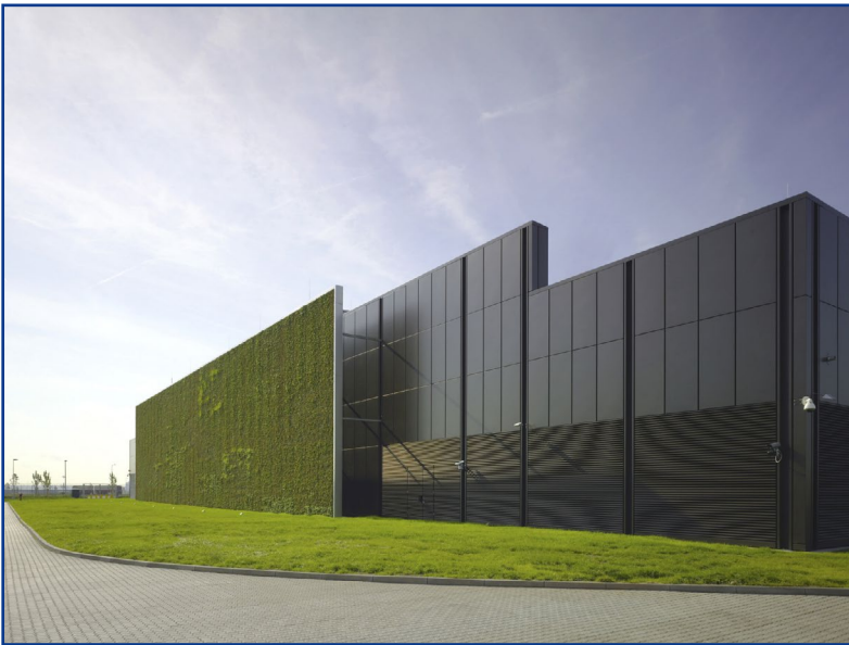
Grüner geht nicht: Das Rechenzentrum der Citibank in Frankfurt mit lebender „Adiabatik“ an der Wand war das erste von LEED Platinum-zertifizierte Rechenzentrum Deutschlands. (Bild: Christian Richters via TTSP HWP Planungsgesellschaft)
