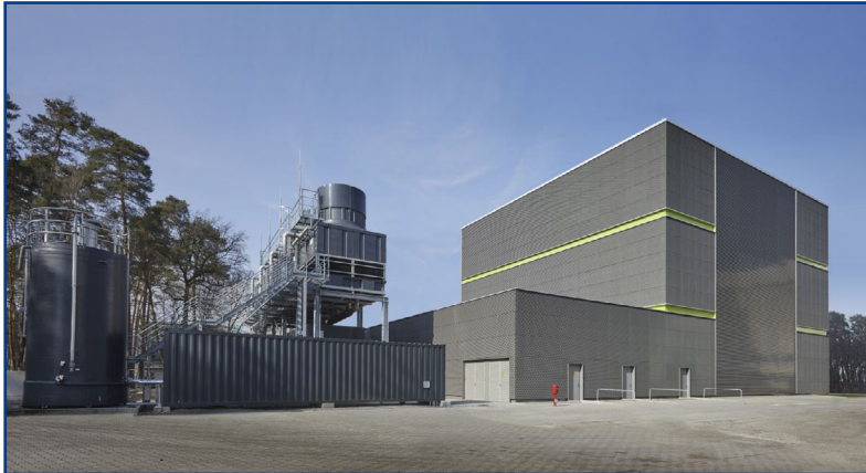
Mit gutem Beispiel voran: Die Abwärme aus dem „Green IT Cube“ auf dem GSI/FAIR-Campus, einem der leistungsstärksten wissenschaftlichen Rechenzentren der Welt, beheizt ein Büro- und Kantinegebäude. (Bild: TTSP HWP Planungsgesellschaft)
